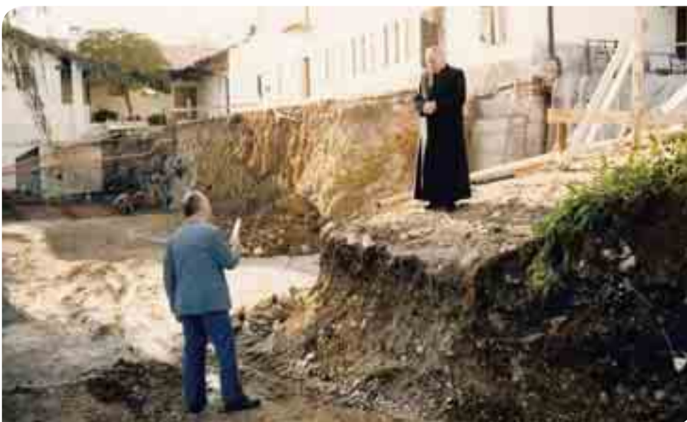
Mons. Ducoli visitava spesso il cantiere e seguiva personalmente i lavori del Centro.
